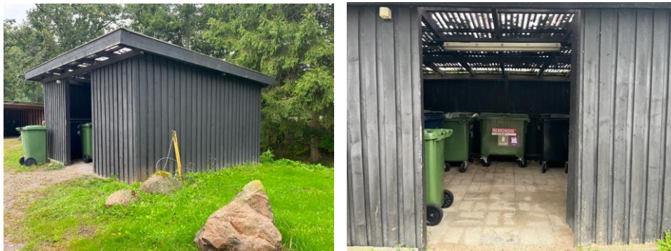
Billederne ovenfor viser skuret til renovation (pkt. nr. 2). Bygningen måler 4,6 x 4,2 m.
